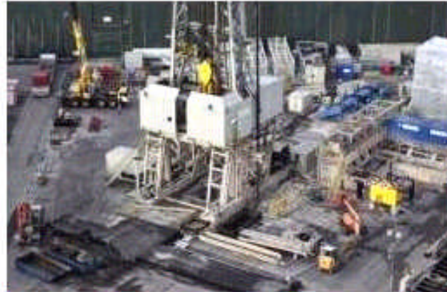
Der inzwischen abgebaute Geothermie-Bohrturm auf dem Areal des Werkhofes Kleinhüningen. Foto: Keystone
