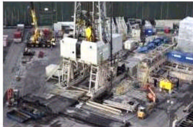
Der inzwischen abgebaute Geothermie-Bohrturm auf dem Areal des Werkhofes Kleinhüningen. Foto: Keystone
