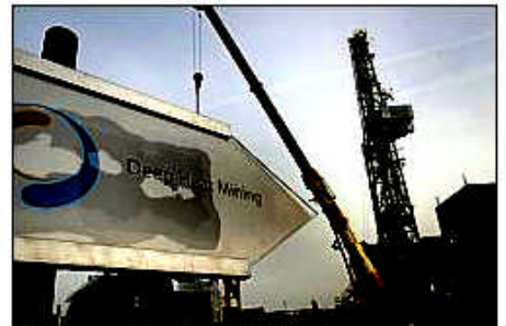
Geothermie-Projekt in Basel. (Bild: Keystone)
